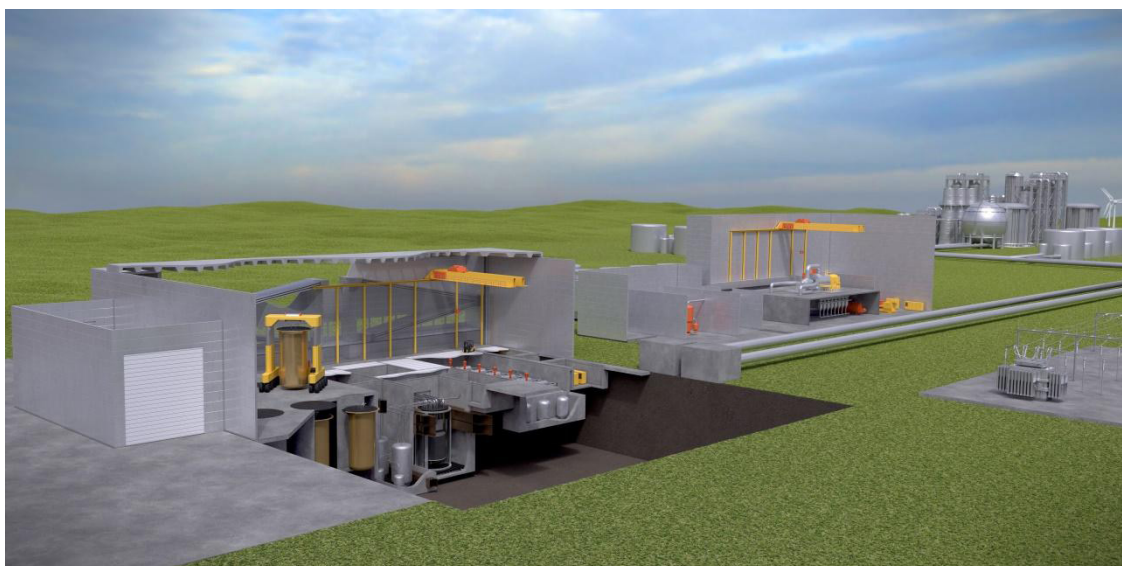
Joonis 1 Terrestrial IMSR reaktoriga elektrijaama läbilõige
