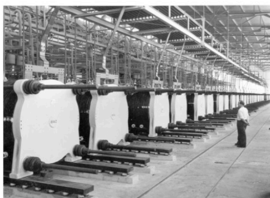
Joonis 3.2. Esimesed tööstuslikud leeliselised elektrolüüserid, mõlemad võimsusega 135 MW. Vasakul – Ryukani elektrolüüsijaam (1929-1970), paremal – Glomfjordi elektrolüüsijaam (1953-1991), mõlemad Norras. Tarnija: Norsk Hydro (praegu NEL Hydrogen) (NEL 2015).
